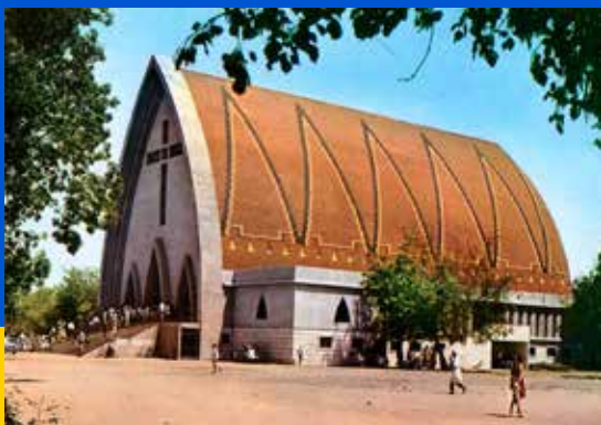
La cathédrale Notre Dame de l'Assomption avant la destruction de la toiture.
